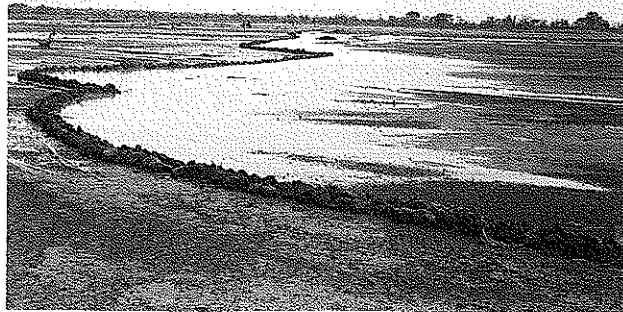
Photo 74 La diguette en pierre retient l'eau sur le glacis.
