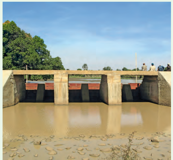
Mit deutscher Unterstützung gebauter Kleinstaudamm in Mali
