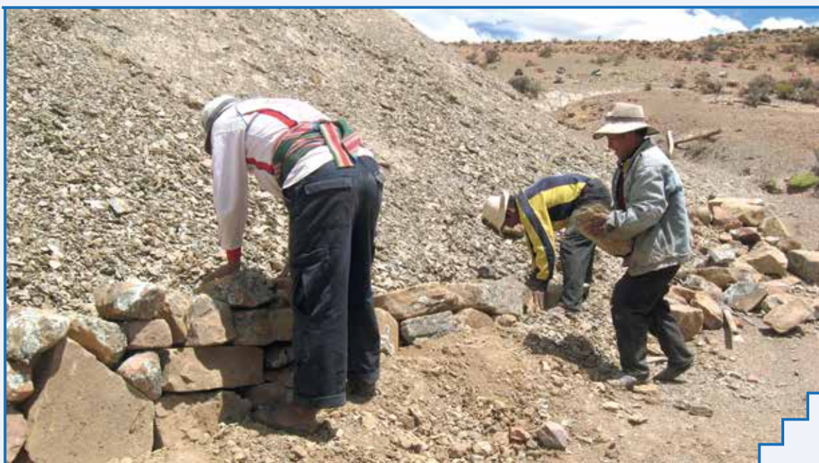
▲ Construcción de un cinturón de protección al pie de un atajado.
