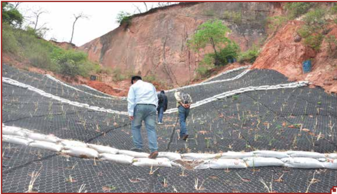
▲ Medidas biofísicas para el control de áreas degradadas, Caigua - Villamontes (Tarija).
