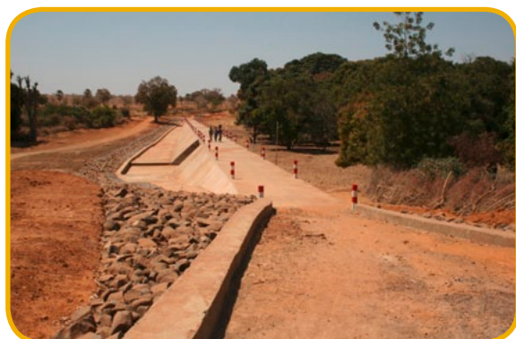
Photo 19 : Tiembougou dam bridge in cyclopean concrete
