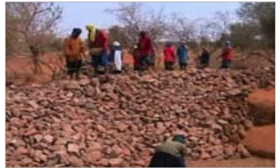
Fermeture d'un ravin par une digue filtrante. Source : PGRNG Mauritanie
