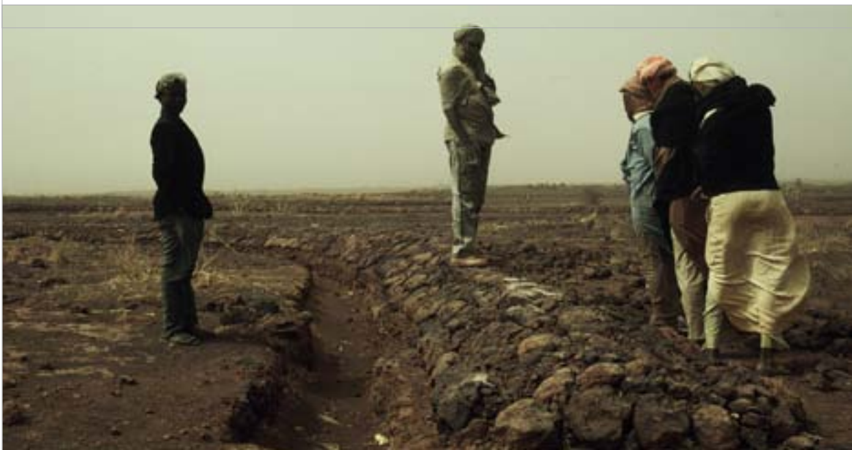
Une banquette inspectée par des techniciens © GIZ / Martina Wegner
