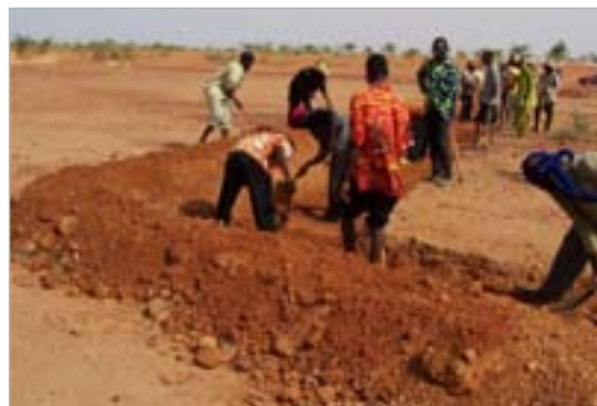
Construction des banquettes. Source : CILSS
