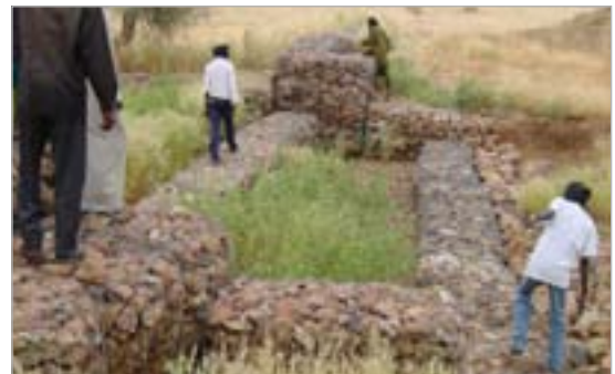
Déversoir d'une digue filtrante avec bassins de dissipation. Source : PGRNG Mauritanie
