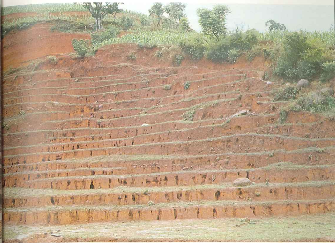
Abb. 4: Nicht ausreichend fest verbaute Terrassenfronten erodieren in kürzester Zeit.
