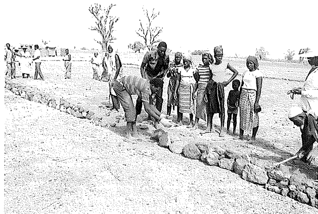
Photo 104 Le chantier: construction de la diguette.
