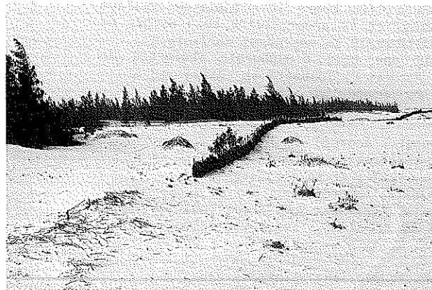
Photo 60 Fixation de la dune côtière: à droite, la plage de sable; au centre la grande palissade en panneaux de N'guer.
