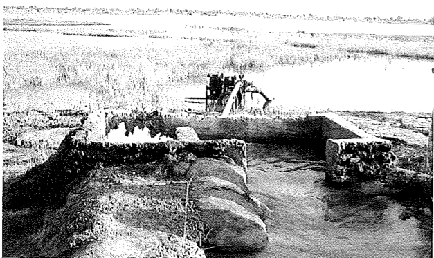
Photo 38 Le bassin de réception avec ces deux parties: à gauche, le bassin d'amortissement; à droite, le bassin de calme.
