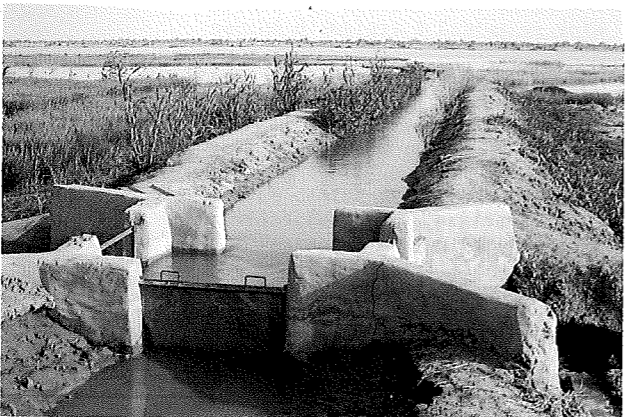
Photo 39 Le canal principal et un répartiteur, tous construits à la main.
