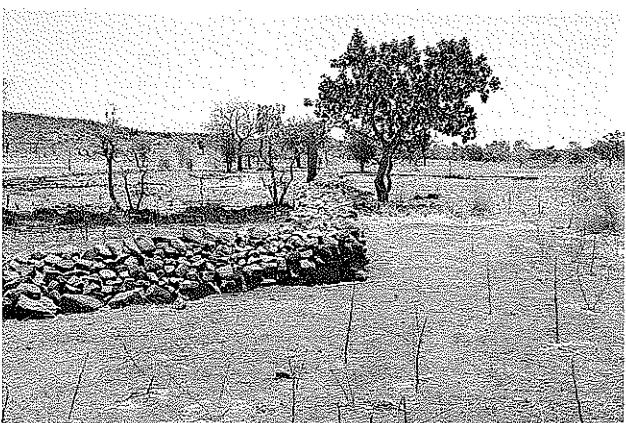
Photo 86 Digue filtrante terminée par une aile à Sankondé.
