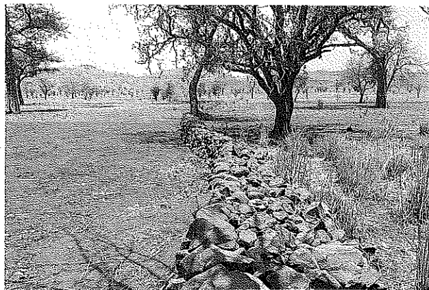
Photo 83 Digue filtrante à Sankondé, talus vertical à l'amont, talus en pente douce à l'aval.
