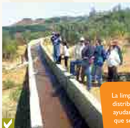
Limpieza de canales para agua de riego
