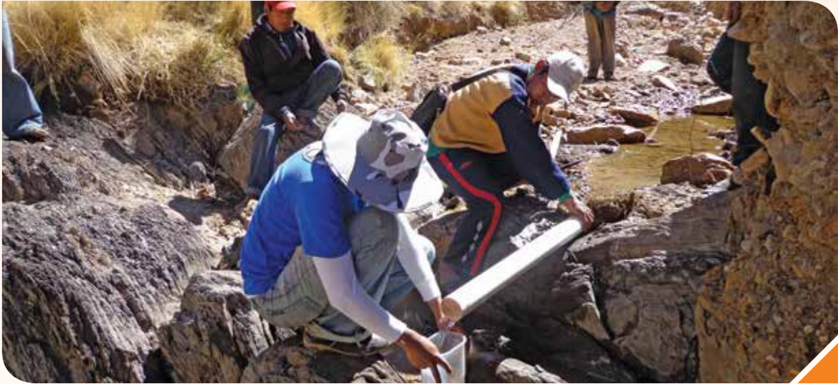
Fotografía 5. Aforo de manantiales (método volumétrico)
