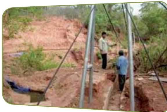
Tramo de conducción repuesto
