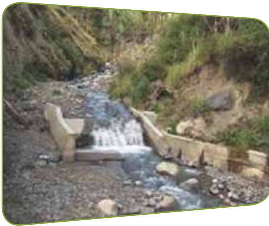
Obra de toma en Palca
