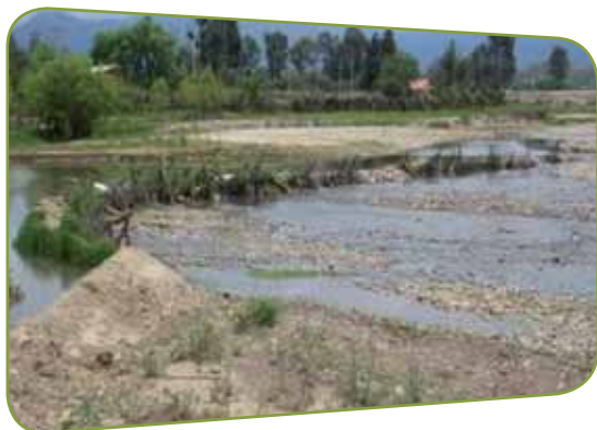
Encauzamiento hacia la toma del río
