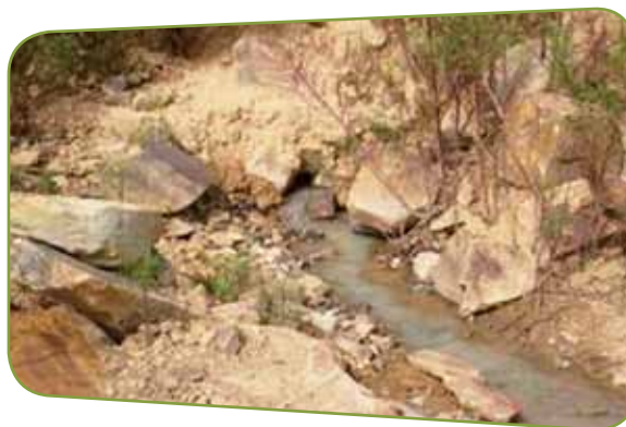
Agua que filtra de la presa
