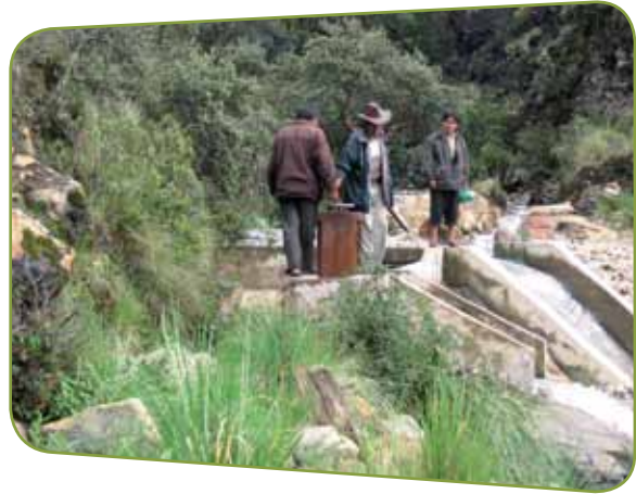
Mantenimiento de la toma en Chajwaya
