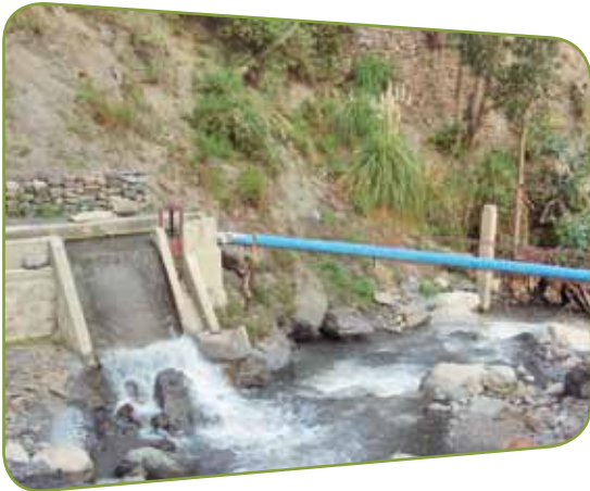
Obra de toma en Palca
