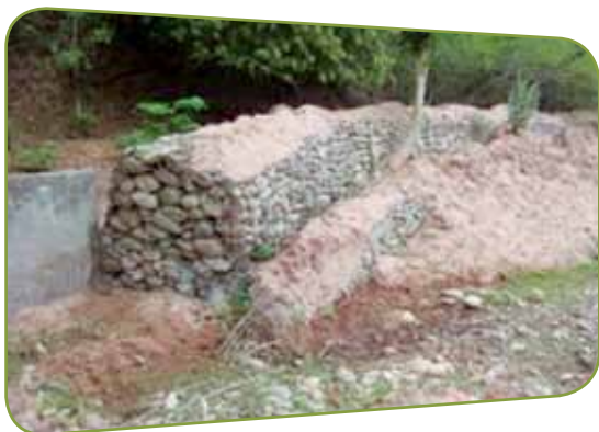
Gaviones de protección para el canal
