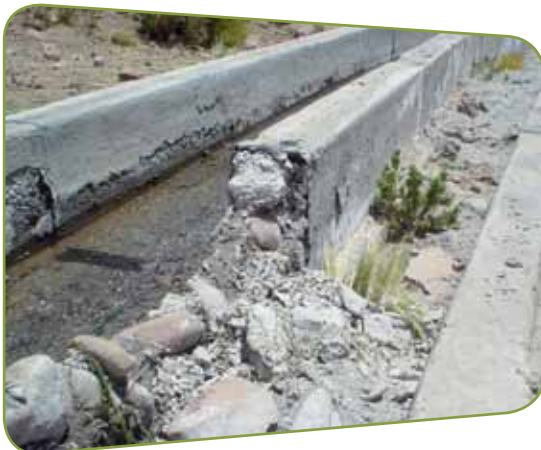
Tramo de canal desmoronado por mala calidad de la obra en Cachi-Cachi, otros tramos aceptables
