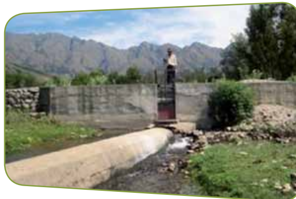
Obra de toma en el río
