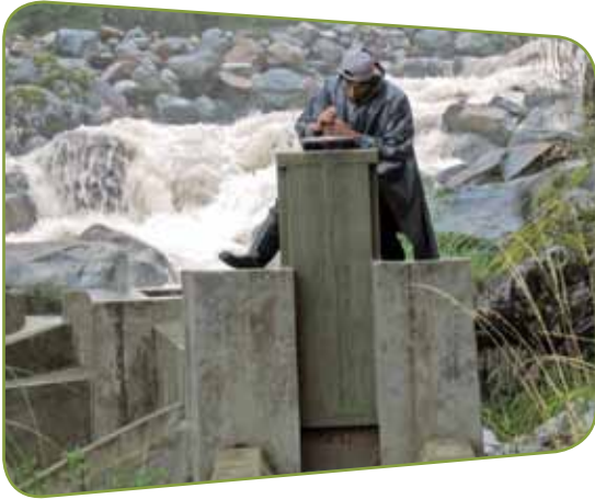
Operación de la compuerta en Cochipata
