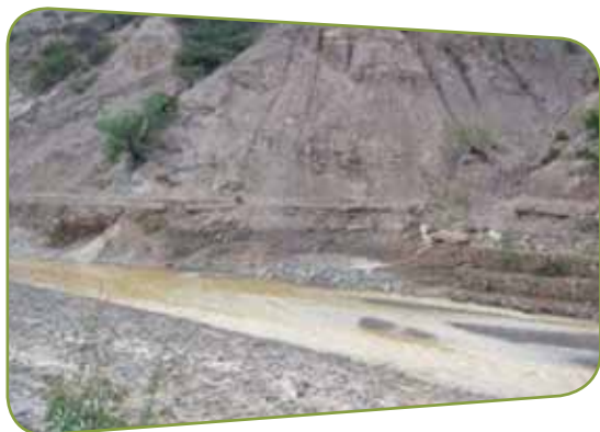
Deslizamiento de ladera en Kellaja Chica
