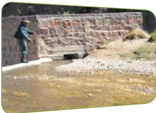
Obra de toma Cohani
