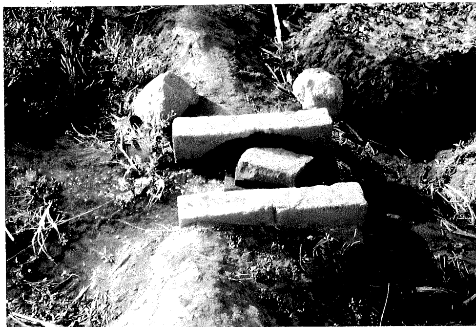
Abb. 14. Perimeter Tégourou rechts, geschlossener Auslaßschacht der Rohrbewässerungsanlage.
