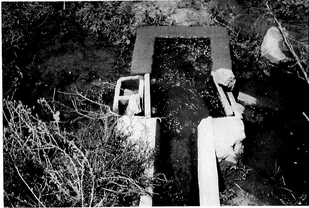
Abb. 12. Einlaufschacht der Rohrbevässerungsanlage.
