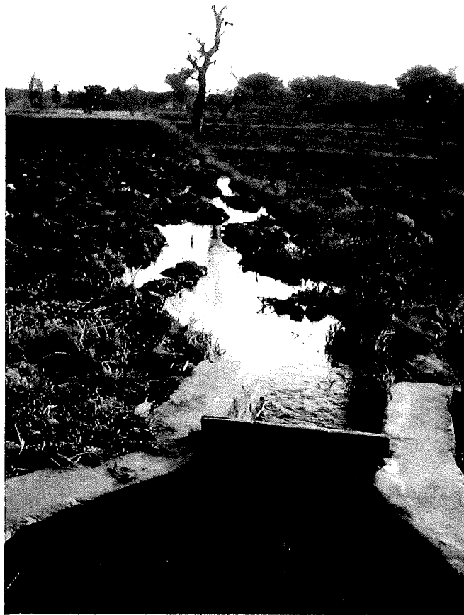
Abb. 16. Perimeter Tégourou links, 1. Verteilerbauwerk.
