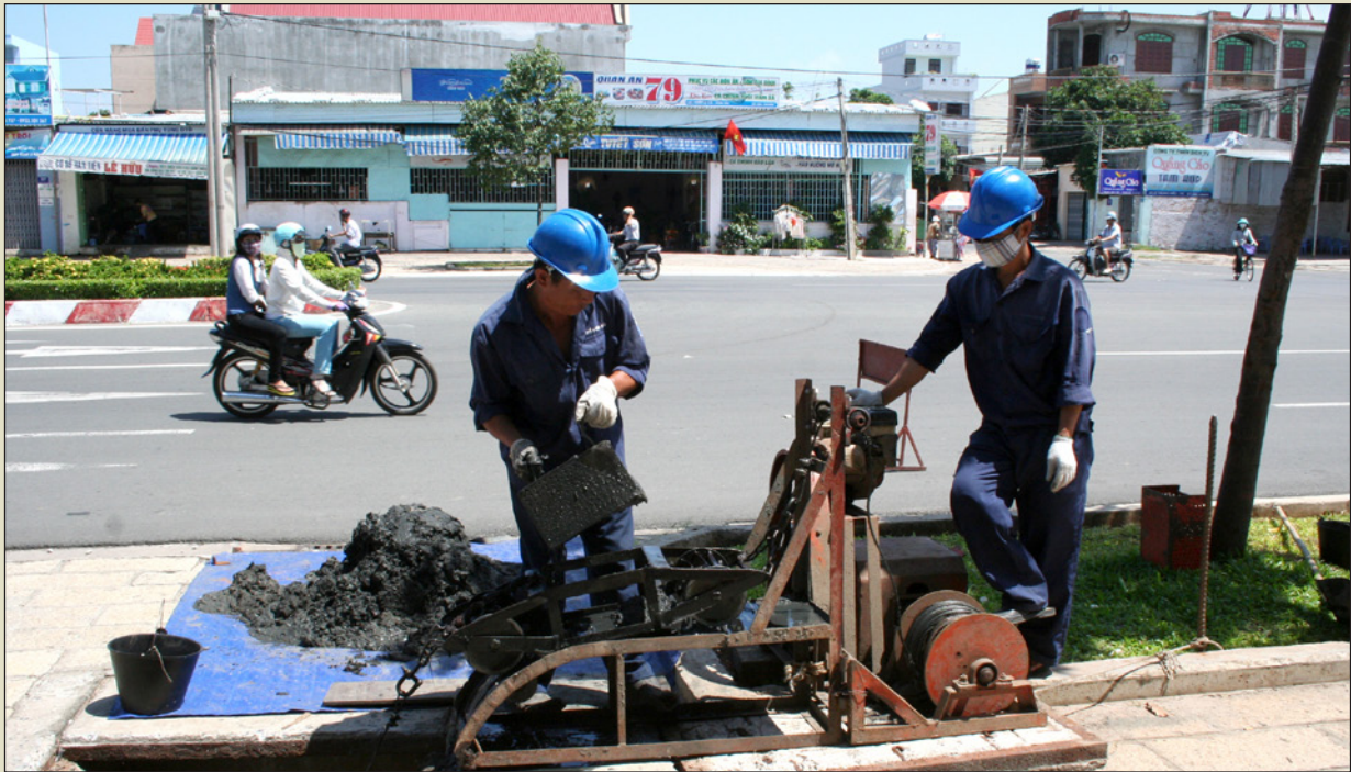
Bild: Mitarbeiter eines Abwasserunternehmens bei Kanalreinigungsarbeiten, © Frank Pogade/ GFA Consulting Group GmbH
