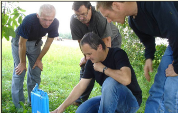
Bild 2: IWAS Ukraine – Einbau Durchflussmessung Ablauf in Lviv, © IWAS
